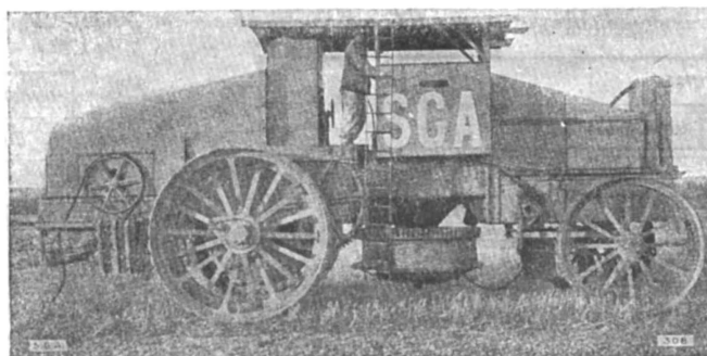
Рис. 38. Электрическая лебедка. На рисунке: в середине барабан для троса, в правом конце лебедки двигатель внутреннего сгорания для передвижения лебедки, в левом конце лебедки барабан для кабеля.
